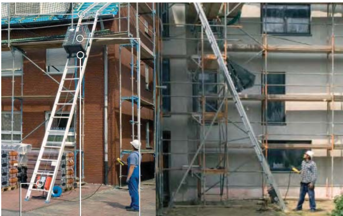
Figura 8.15. Mecanismo elevador Toplift model 234 de Böcker. Fuente: Fabricante Böcker.
